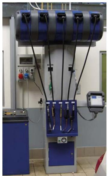
Estações de abastecimento autoportantes de **duas colunas** (pórtico tipo "goleira") conectadas ao sistema centralizado de tubulações e equipadas com carretéis bobinas e outros equipamentos de abastecimento, medição e serviços diversos.
